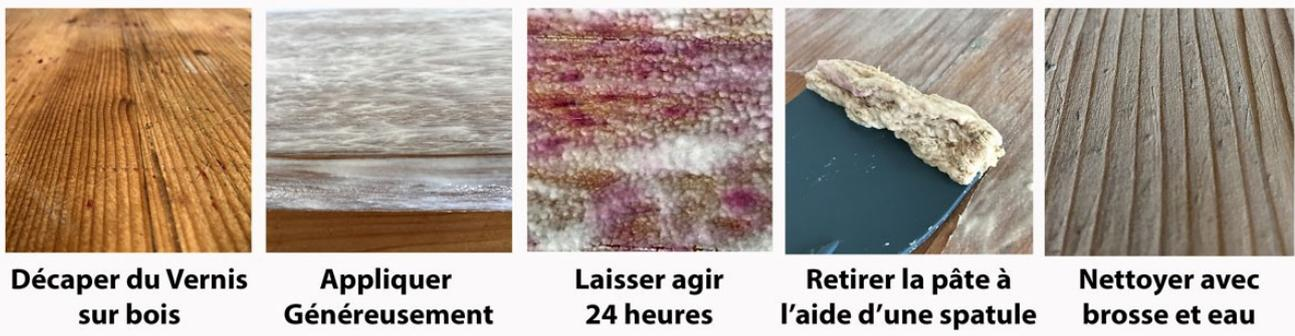
Sous forme de **gel épais**, l'application se fait à l'aide d'une brosse, d'un rouleau ou d'un pulvérisateur de type Airless.
